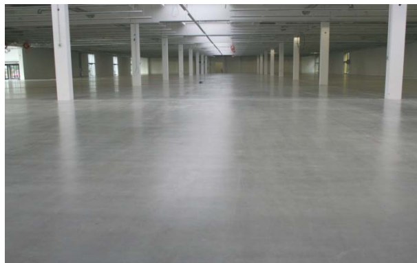
Bild 6: OBTEGO® P-20 + R-400 auf einem neuen, geglätteten Boden in einem Baumarkt: keine Farbtonintensivierung und ein seidenmatter Glanz
